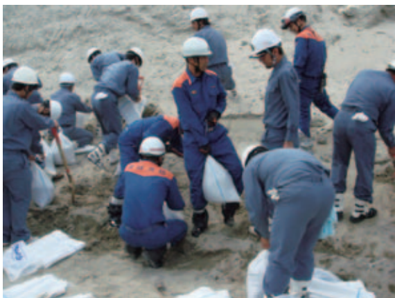
土のう作りの様子
