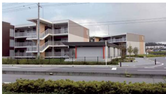
写真1 259世帯が暮らす災害公営住宅団地(いわき市内)
