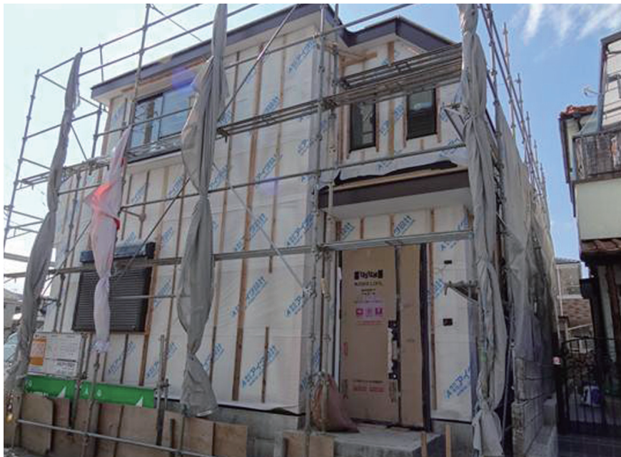
写真3 震災から1年で住宅再建（浦安市液状化被害地区）
