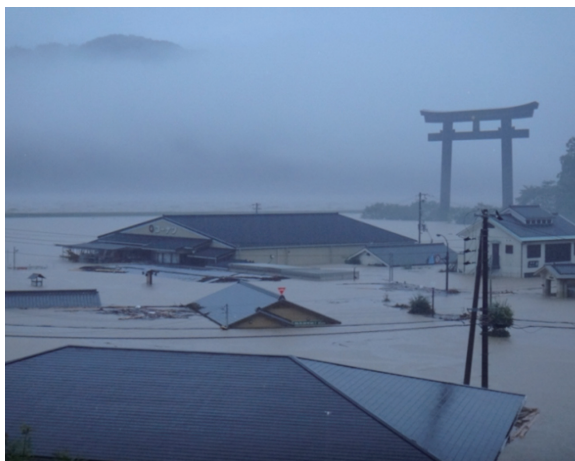
台風12号での浸水状況
