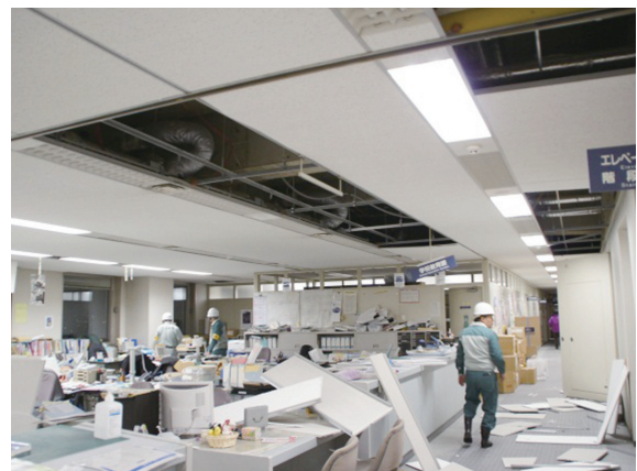
市役所6階の被害状況（平成23年3月15日）
