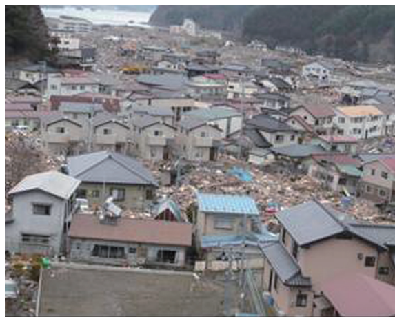
写真1 釜石市鵜住居（平成23年3月14日）
