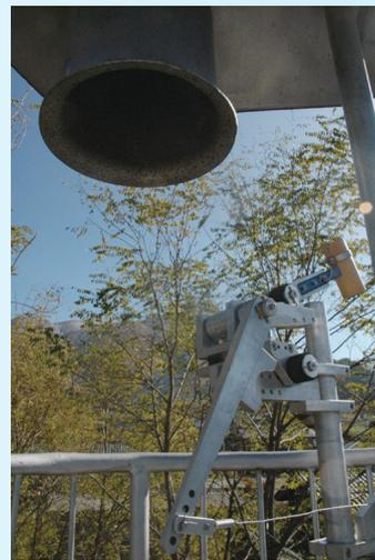
写真⑤『火の見やぐらに設置された地上操作型半鐘叩き装置』
